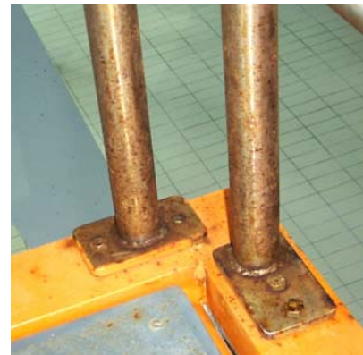
Figur 6 Sveiser i meget utsatt "plaskesone"
